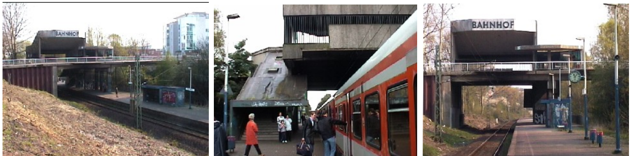
Bahnhof Marl Mitte mit Fußgängerübergang. Die obere Betonhalle ist völlig leer und ohne Funktion.
